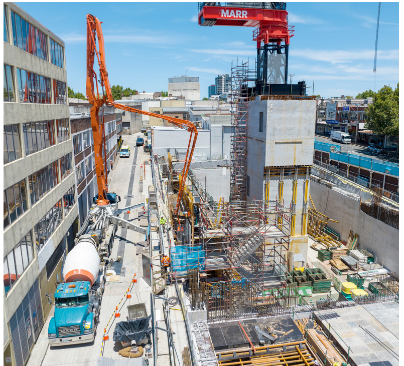
Final station box perimeter wall pour
