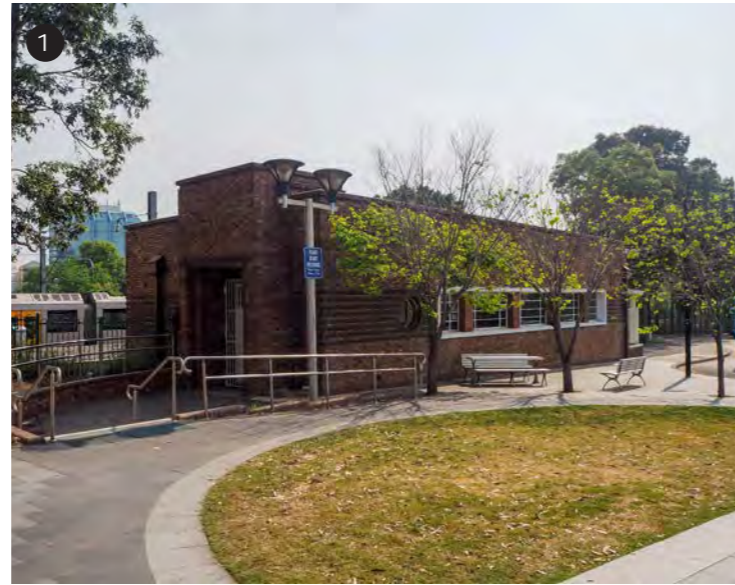
Heritage Parcels Office
